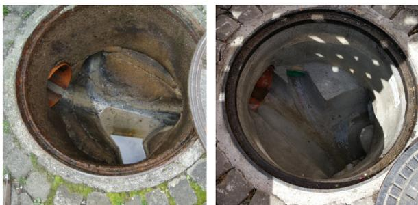
Für die Kanalsanierung neu erstellter Schacht vorher (links) und nachher (rechts) mit sanierter Leitung.
